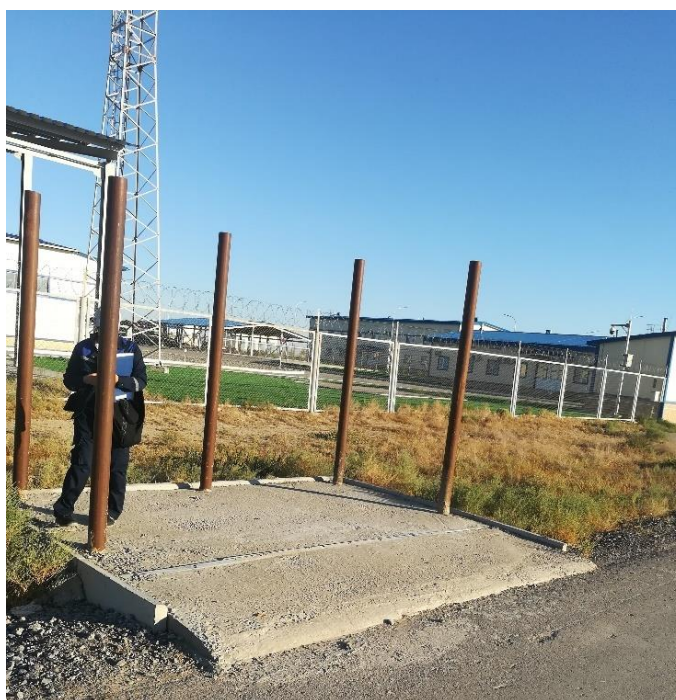
Рисунок 2.2. РЭУ. Строящаяся площадка для сбора отходов.
