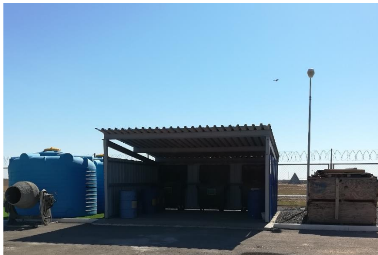
Рисунок 2.1. КС «Коркыт Ата». Площадка для сбора отходов.
